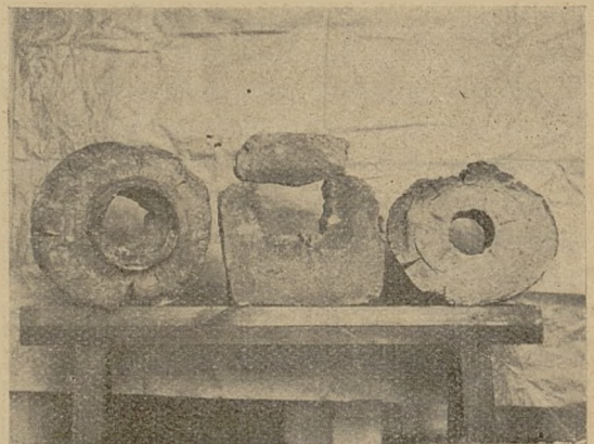
Rys. 2. Drewniane rury wodociągowe i rynny kanalizacyjne.
