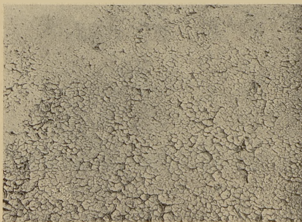
Rys. 3. Zeschnięta skorupa na filtrze wodociągowym.
