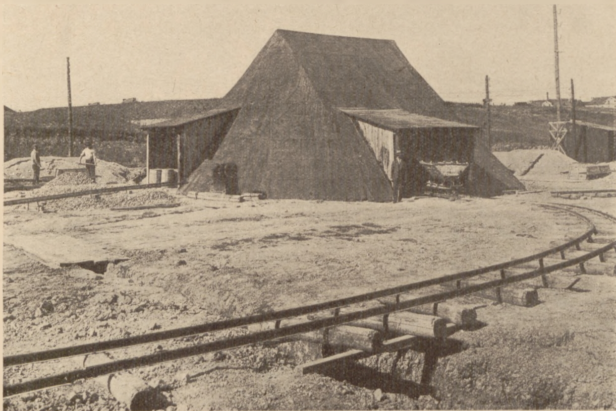
Rys. 10. Widok studni podczas budowy.
