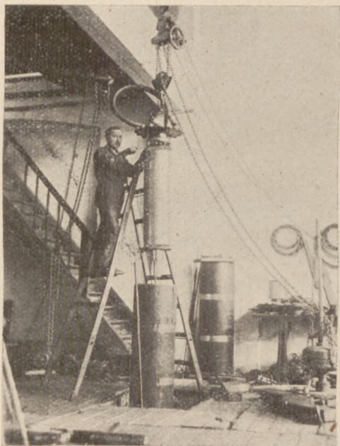
Rys. 1. Montaż silnika »SUW« 8 (500 V, 250 KM, 1460 obr./min).
