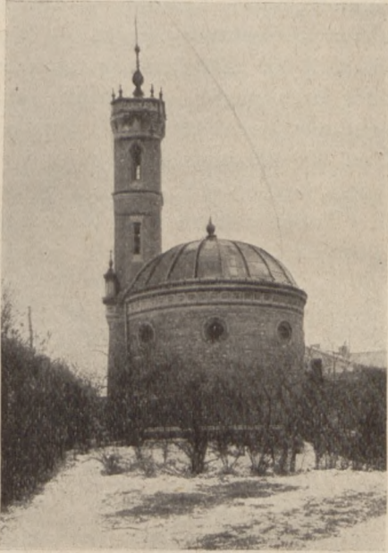
Rys. 3. Wieża ciśnień i zbiornik wodociągów praskich (1869—1896).
