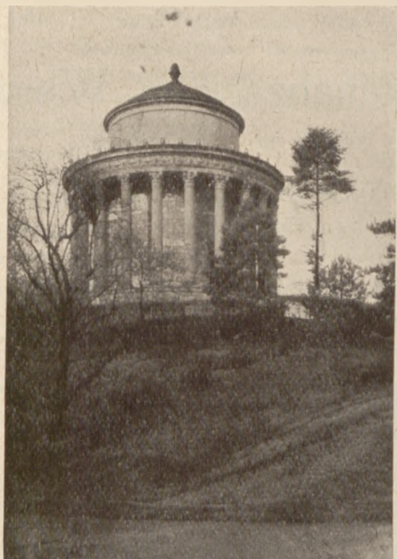
Rys. 1. Zbiorniki wodociągów Markonięgo (1855÷1889).
