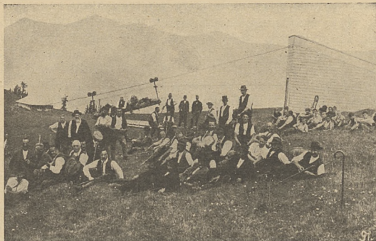
Kolejka linowa na hali Niedernhorn (do fejletonu)
