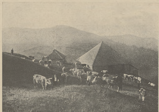
Hala Grubenberg w Grischbachtal
