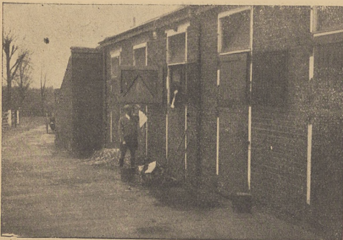
Ryc. 5. Dwudzielne drzwi z okratowaniem dla górnej części.
