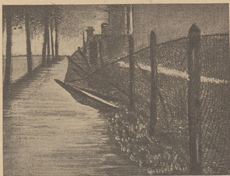
Fig. 1. Widok ogrodzenia z siatki drucianej po gniciu słupów drewnianych.
