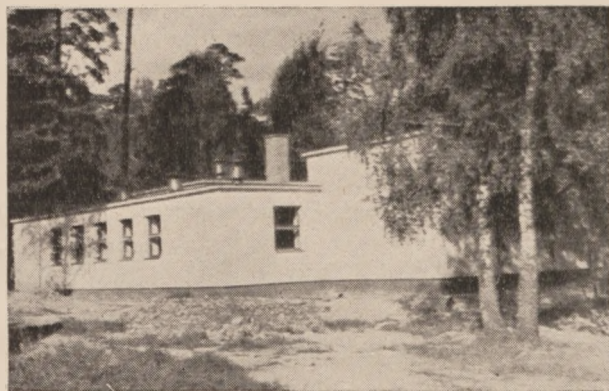
Rys. 6. Widok oczyszczalni od strony południowej
