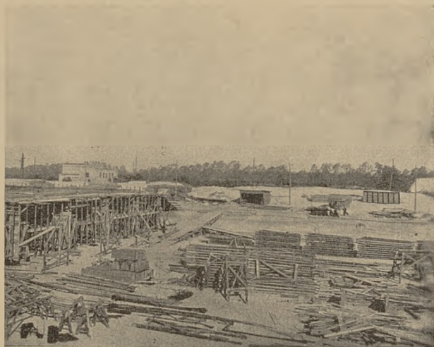
Rys. 1. Fragment z budowy filtrów w Maczkach (16 komór).
