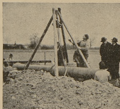
Rys. 7. Układanie przewodu z rur żeliwnych \varnothing 400 mm z elastycznymi połączeniami „Union” w Hamm.
