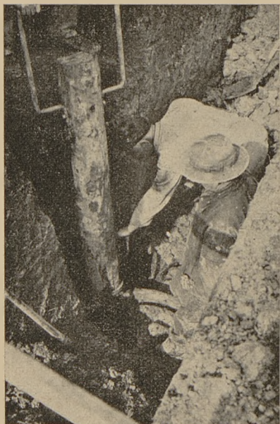
Rys. 6. Układanie przewodu z rur żeliwnych \varnothing 500 mm z elastycznymi połączeniami „Union” w Unna.
