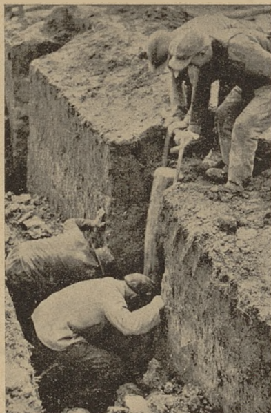
Rys. 5. Układanie przewodu z rur żeliwnych \varnothing 500 mm z elastycznymi połączeniami „Union” w Unna.
