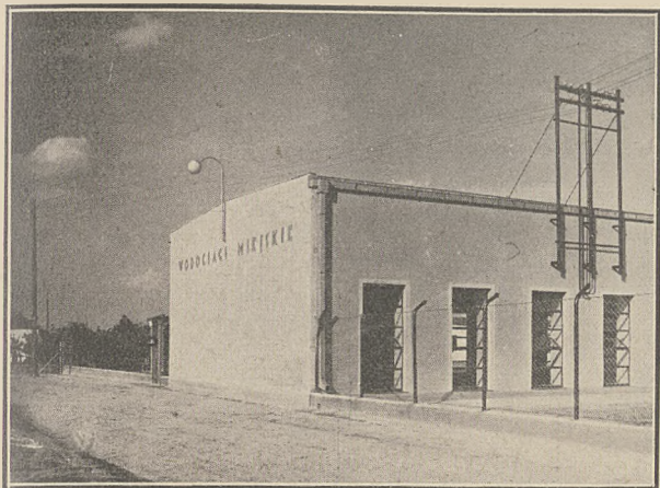
Rys. 3. Wodociąg m. Łucka. — Budynek hali maszyn i pomp.
