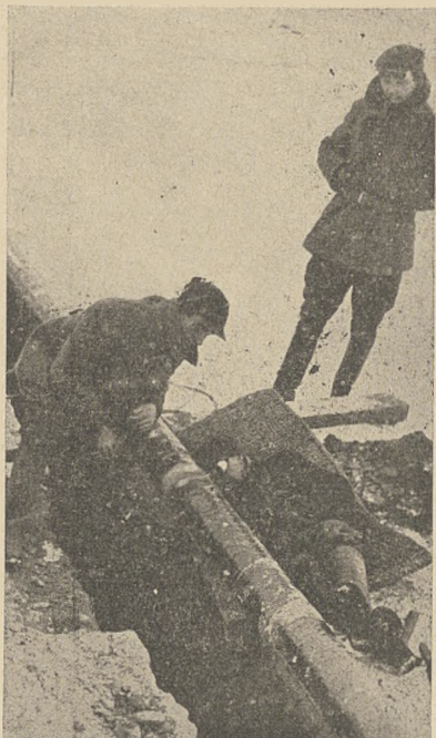
Rys. 6. Wodociąg m. Łucka. — Montaż rurociągu stalowego średnicy 150 mm.
