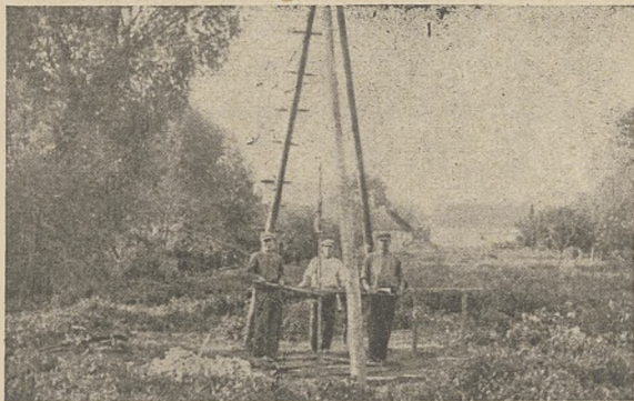
Rys. 20. Wodociągi m. Włodzimierza. — Wiercenie studni \varnothing 3" na terenie ujęcia.
