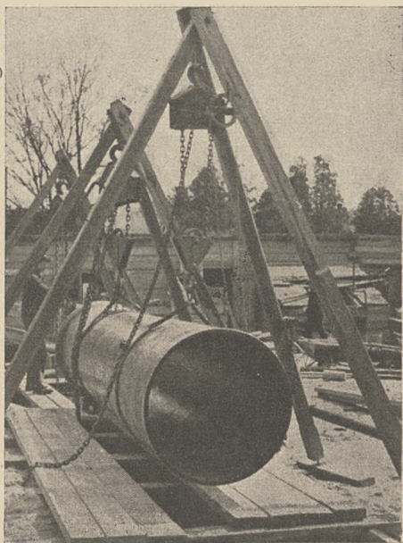
Rys. 10. Opuszczanie rury D = 900 mm.
