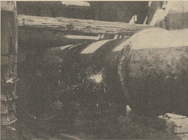
Rys. 6. Przecinanie przewodu przy użyciu palnika acetylenowego.
