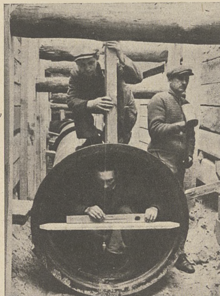
Rys. 11. Ustawianie rury na podejściu do węzła.
