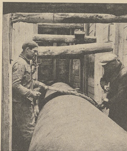
Rys. 14. Uszczelnianie złącza sznurem.
