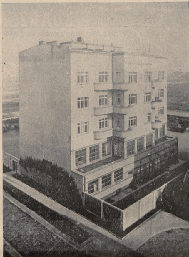
Budynek Głównej Stacji Rozdzielczej M. Z. Elektr. w Gdyni.
