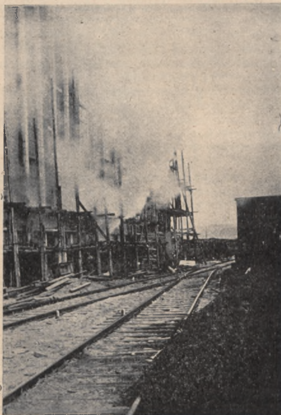
Fragment z nowowbudowanej elektrowni.
