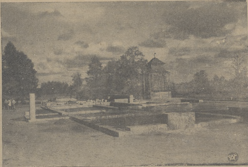
Rzut oka na odbudowane fundamenty domu w Zułowie, w którym urodził się Marszałek Józef Piłsudski.
