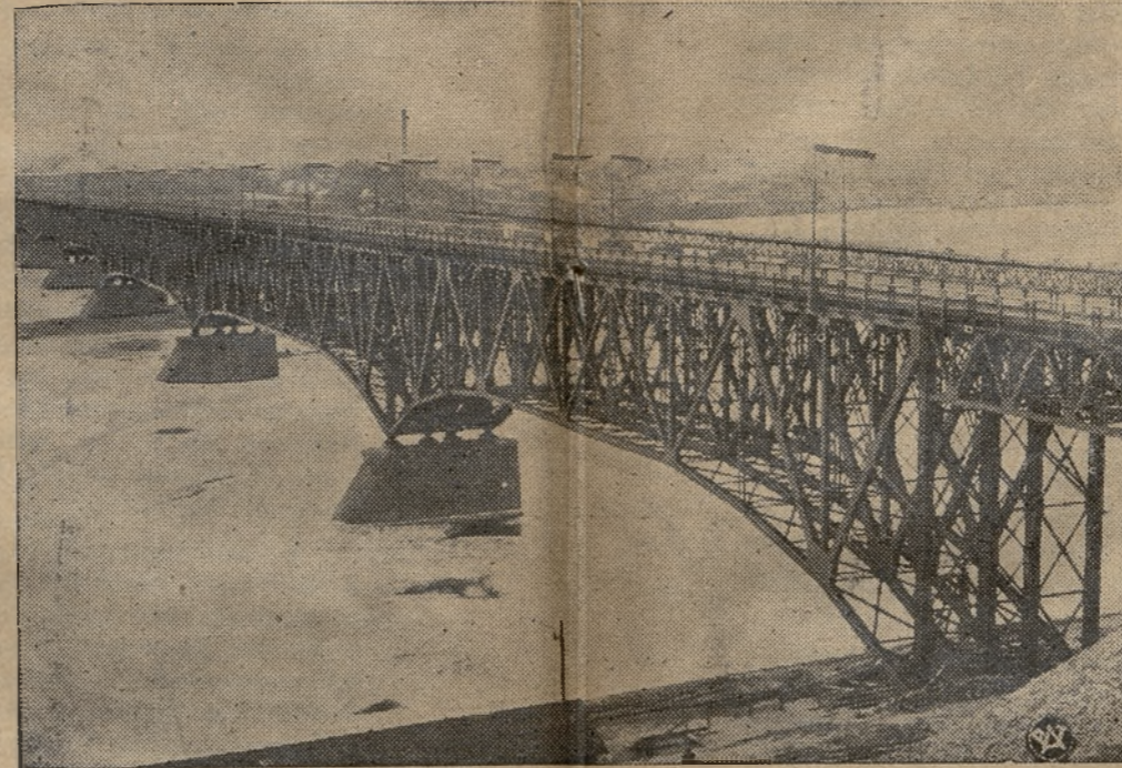
W dniu 19-go grudnia odbyło się uroczyste poświęcenie i otwarcie nowozbudowanego mostu drogowo-kolejowego na Wiśle w Płocku. Most ten stanowi imponującą konstrukcję żelazo-betonową według najbardziej nowoczesnych wzorów techniki. Most ma długości 700 m, przy czym koszt ogólny budowy sięga 15 milionów złotych.
