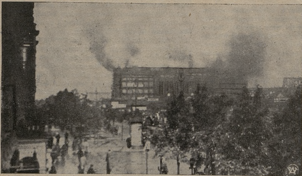
Dnia 6 czerwca z nieznanых przyczyn powstał groźny pożar budującego się wielkiego dworca w Warszawie. Po wielkich wysiłkach udało się pożar zlokalizować.
