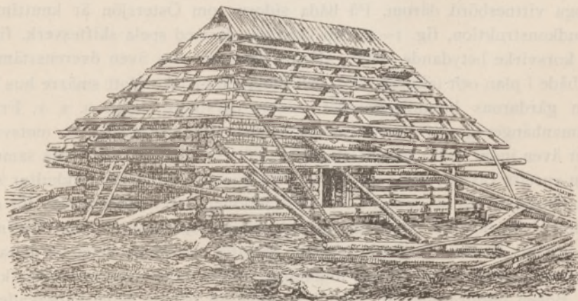
Fig. 3. Huzulisk timrad byggnad under uppförande. Efter Moszynski.
