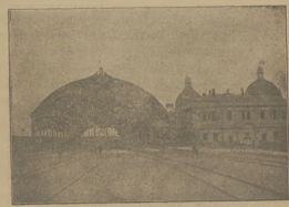
Budynek i hala oszklona od strony zachodniej.
