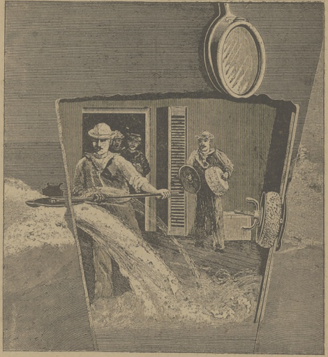
Jak się na pełnym morzu naprawia uszkodzone okręty? (Sposób zatykania dziur w pancerniach okrętowych systemem Inż. Colome).
