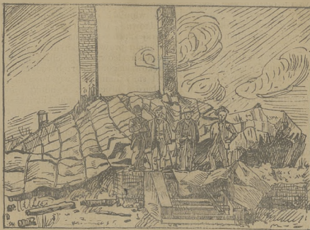
Dom burmistrzowski Sokółowa p. Chodźzińskiego. Dom cały spalony i jakby płótnem balonowym przykryty blaszanym dachem, który spada.
