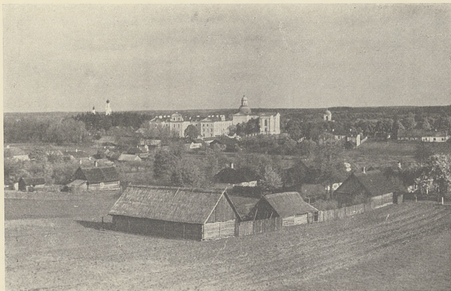
ŻYROWICE. — Widok klasztoru niegdyś OO. Bazylianów.
