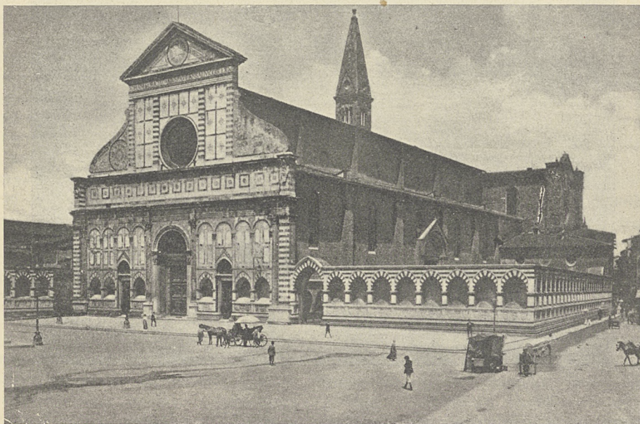
FLORENCJA. — Kościół M. Bożej „Nowej“, miejsce obrad Soboru Florenckiego 1439 r.
