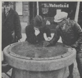
W Berlinie zainstalowany został na Placu Poczdamskim, koło wejścia do podziemnej kolejki olbrzymi postument kamienny z wygwierzonym planem miasta. (Atlantic).
