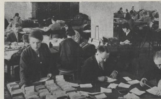
6) Sto! Stacja! Biuro Kontowców! Wstąpił! Czek — już leży na stole przed okiem bystrzego „cełnika”. Wzór podpisu, podpis na czeku — identyczne. Sprawdzono; wszystko w porządku, kontrabandy nie ma. Gotowie! Jazda dalej! Następnym etap — konto właściciela. Pokrycie? Jesli! Zmniejszyć je o kwotę czeku! Zapisać! Odetnąć! Zatatulone! Dalej! w drogę!
