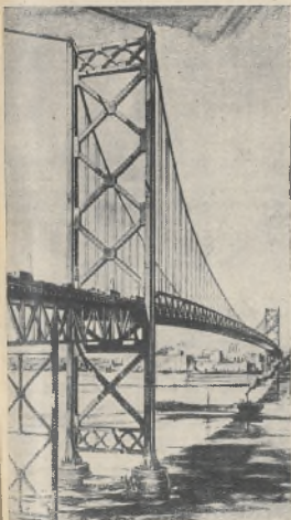
Widoczny na świetle most wiszący, długości 7.400 stóp, został zbudowany pomiędzy miastami Detroit i Sandwich. Po wysokości i rozpiętości mostu możemy szcenić o trudnościach, jakie nastąpiła praca tysiącznych rzesz robotników
