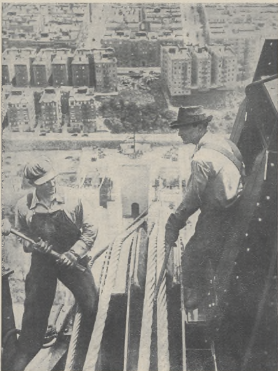
Robotnik, zatrudniony przy budowie olbrzymiego mostu lub drapacza chmur, musi posiadać pota wszelkimi kwalifikacjami odporność na zawroty głowy.
