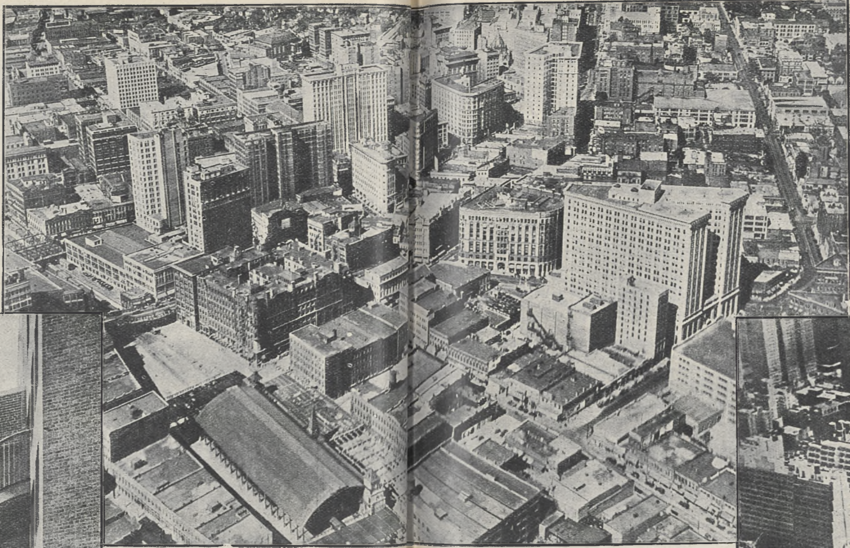
Widok z lotu ptaka na miasto Atlanta w stanie Georgia, liczące 250 000 mieszkańców.
