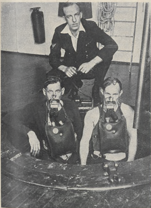
Najnowszy wynalazek dla nurków, przeznaczony jako środek ratunkowy dla załóg statków podwodnych.
