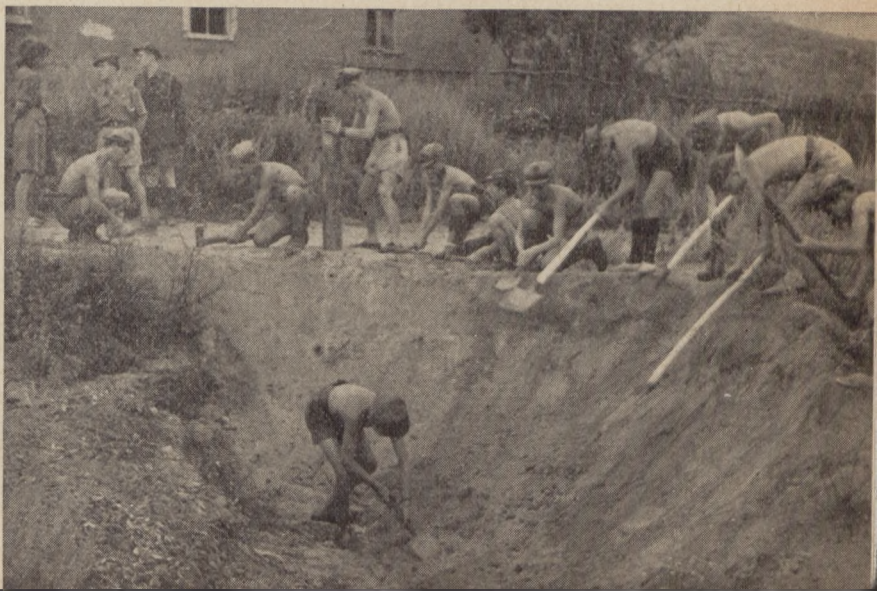
Poolse padvind ers bij het aanleggen van wegen
