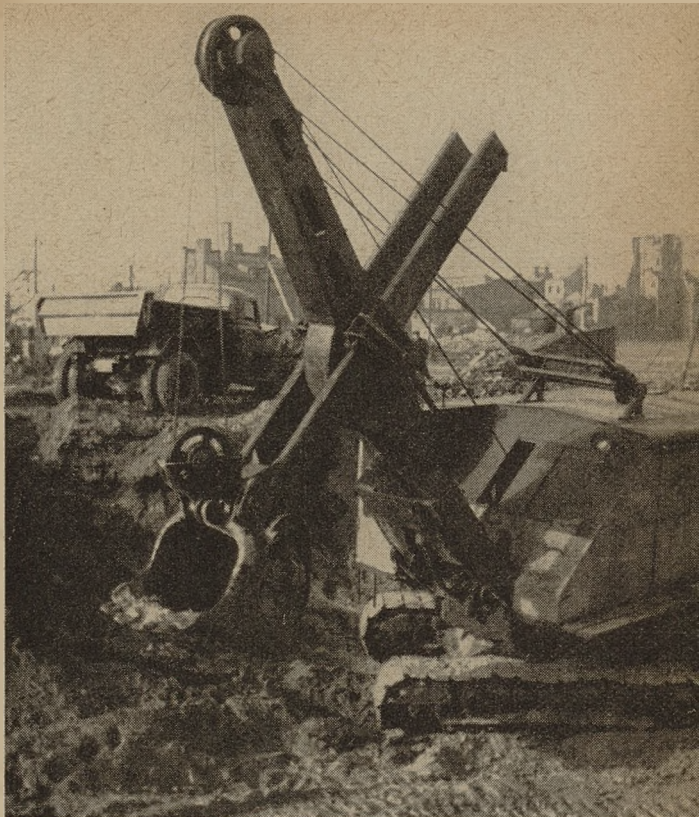
Deze elektrische griper verplaatst 600 m 3 aarde in zes uur
