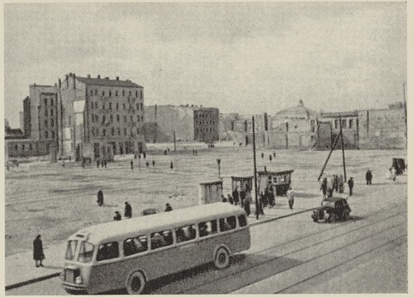
De plaats in 1949, waar het „Culturele Centrum” zal verrijzen.
