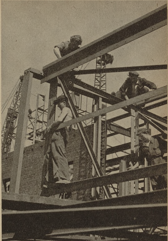
De bouw van een nieuw electriciteitsbedrijf in Jaworzno maakt snelle voortgang
