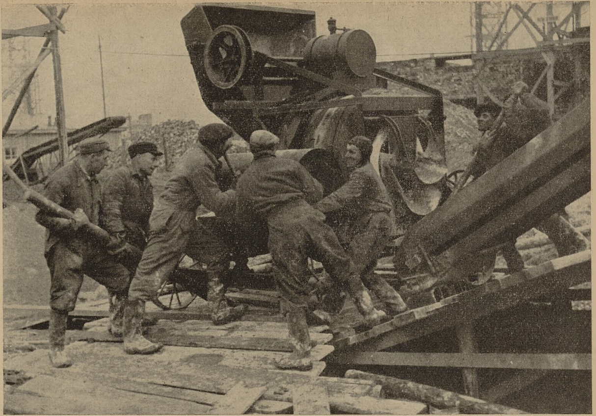
Op het bouwterrein van Nowa Huta wordt gebruik gemaakt van betonmachines
