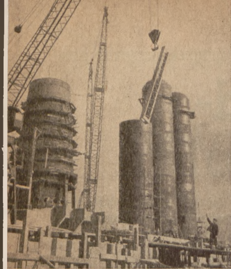
De bouw van een nieuwe hoogoven in het complex „Częstochowa”
