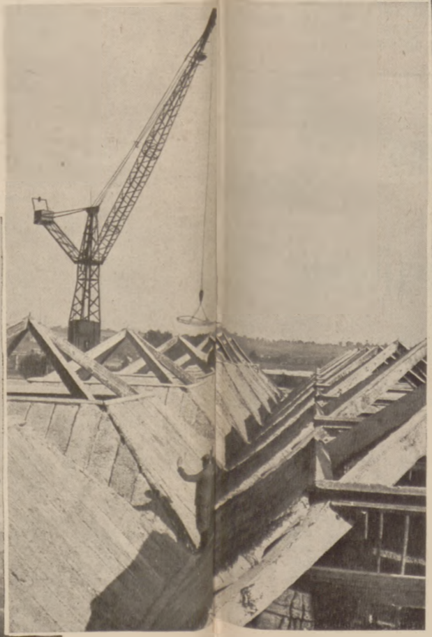
Fabrieken in Częstochowa. Niet ver van Kraków wordt een fabriek gebouwd. De montage van het dak op een der reusachtige fabriekshallen
