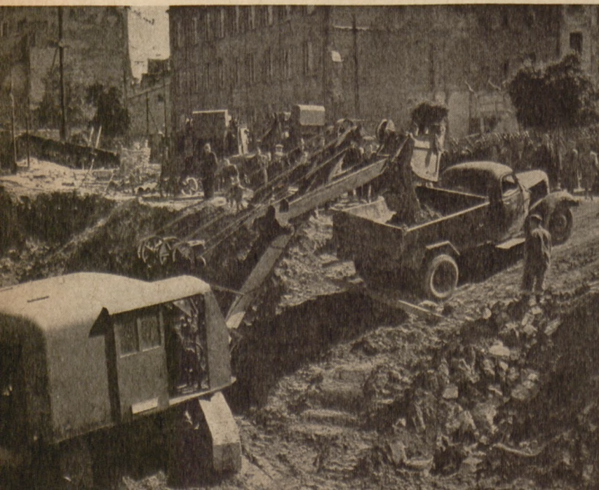
Werk in uitvoering in de woonwijk Marszałkowska te Warszawa
