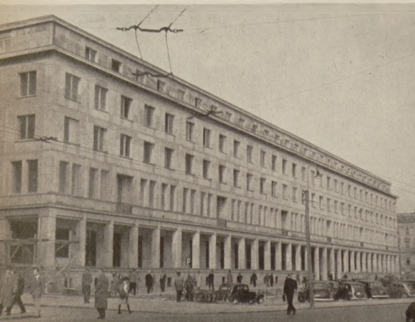
Het nieuwe gebouw te Warszawa waarin het economisch planbureau is gevestigd
