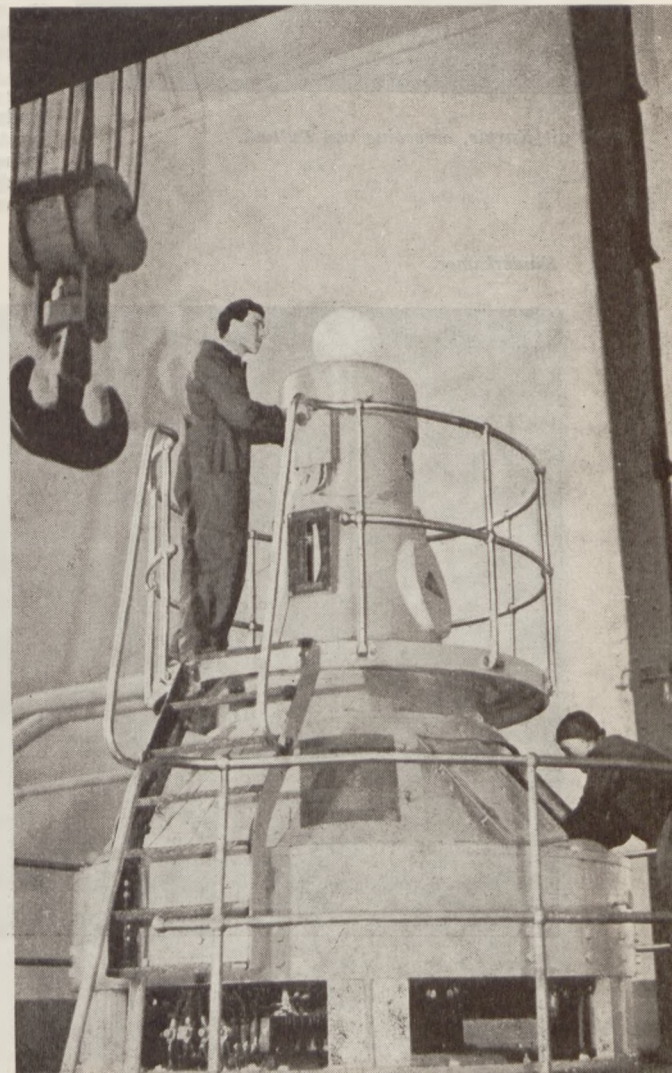
De montage van een turbine in de grote elektrische centrale te Dychów.
