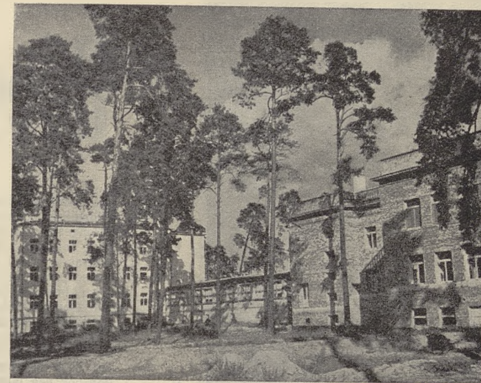
Een vleugel van het ziekenhuis Dziekanów.
