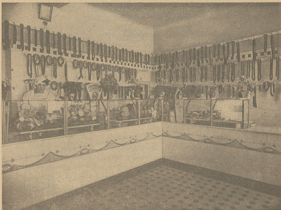
Wnętrze wędliniarni przepisowo urządzonej. Podłoga kamienna, stół sprzedażowy wykładany tafelkami; towary oddzielone od klientów płytami ze szkła; ściany wykładane tafelkami do sufitu; haki do kielbas porcelanowe.
