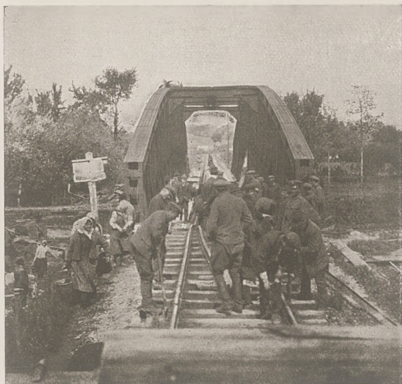
Budowa mostu kolejowego na rzece przez załogę pociągu pancernego.
