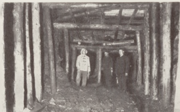
Miejsce spotkania się przodków przebijanego z dwóch stron przekopu. Od lewej widoczni: inż. Hanke, kier. budowy szybu; p. Soremski, technik mierniczy; inż. Jakubowski, kier. biura miern.
