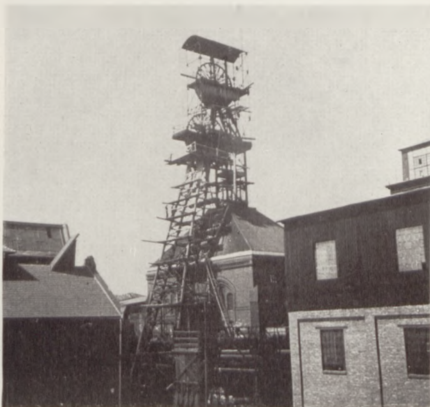
Wieża szybu »Antoni« podczas wzmacniania przed zawieszeniem skipów.
