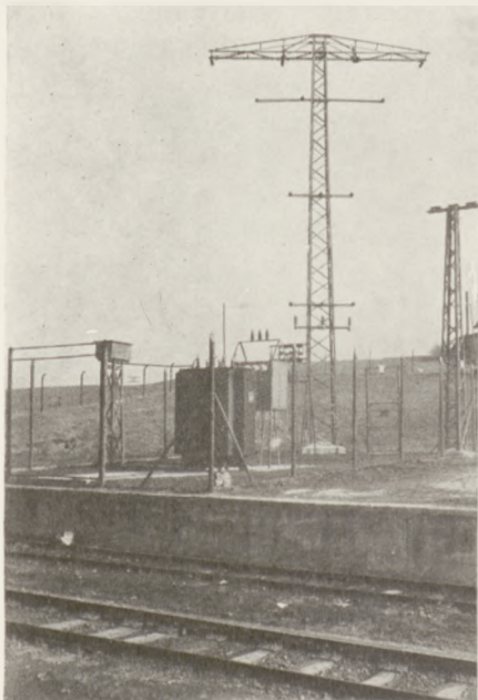
Ryc. 16. Napowietrzna stacja transformatorowa na szybie pow. III kop. »Anna«.
