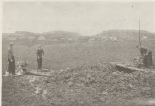
Ryc. 10. Budowa przewodu napowietrznego 20 kV na słupach drewnianych do mleczarni w Bełżnicy.
