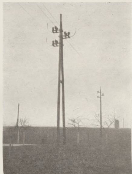
Ryc. 9. Skrzyżowanie szosy Wodzisław—Pszów przewodem 20 kV na słupach drewnianych i wsporczych izolatorach.
