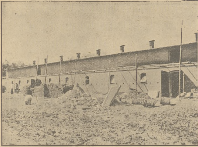
Rys. 5. Wzorowa chlewnia zarodowa w Gutowiu Małym, kryta papą smołowcową. Okazało się, że pokrycie papą spowodowało, iż w zimie w chlewie było cieplej, a w lecie chłodniej, niż w budynkach, krytych blachą, przytem zapobiegano opadaniu skropli wewnątrz budynku.
