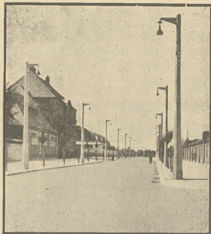
Słupy 8,00 m wysokie, o wadze ca 1 500 kg, wykonane w Poznaniu.
