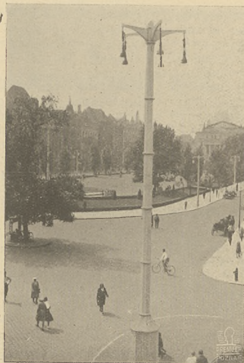
Słup 13,80 m wysokości, trzon o wadze ca 3600 kg, wykonany przez firmę Stanisław Trawczyński w Poznaniu.
