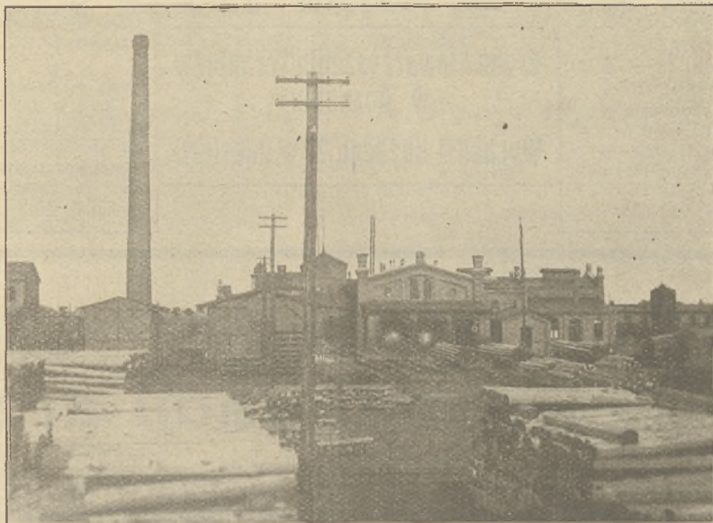
Fig. 1. Widok frontowy na cylindry impregncyjne Zakł. Impregncyjnych Wielki Chetm.
