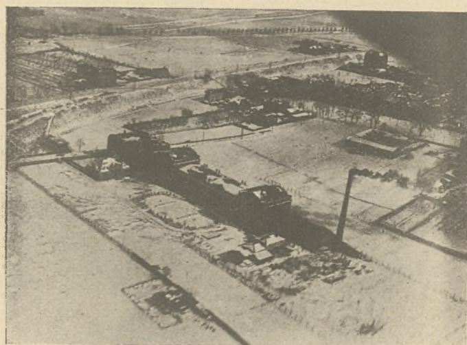
Zdjęcie ukośne ulicy Św. Wawrzyńca Wysokość 100 m., — śnieg.
