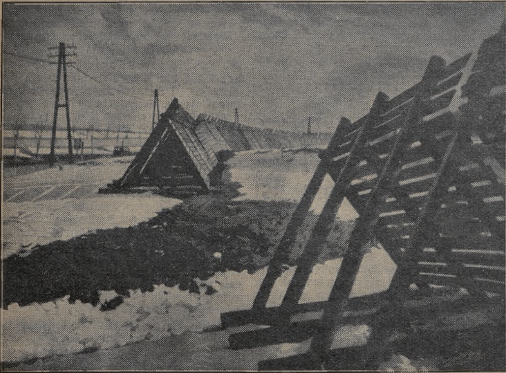
Holzwälle schützen Straßen vor Schneeverwehung
