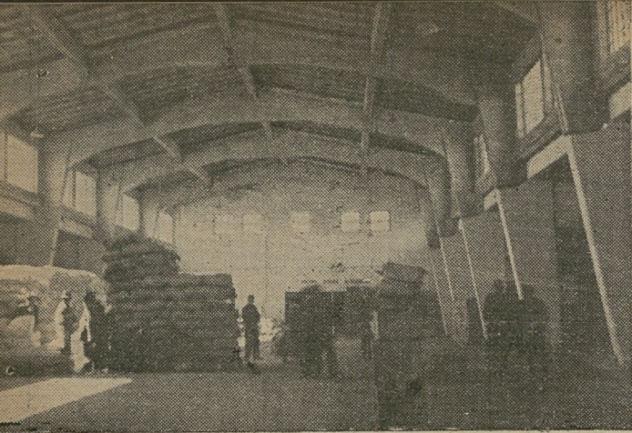
Wnętrze magazynu przejściowego
