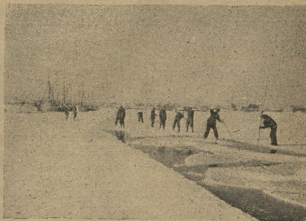
Wyrabianie kanału w lodzie w celu oswobodzenia gdyńskich kutrów.
